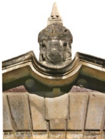
An der Fassade befindet sich ein Wappen mit folgender Inschrift:
