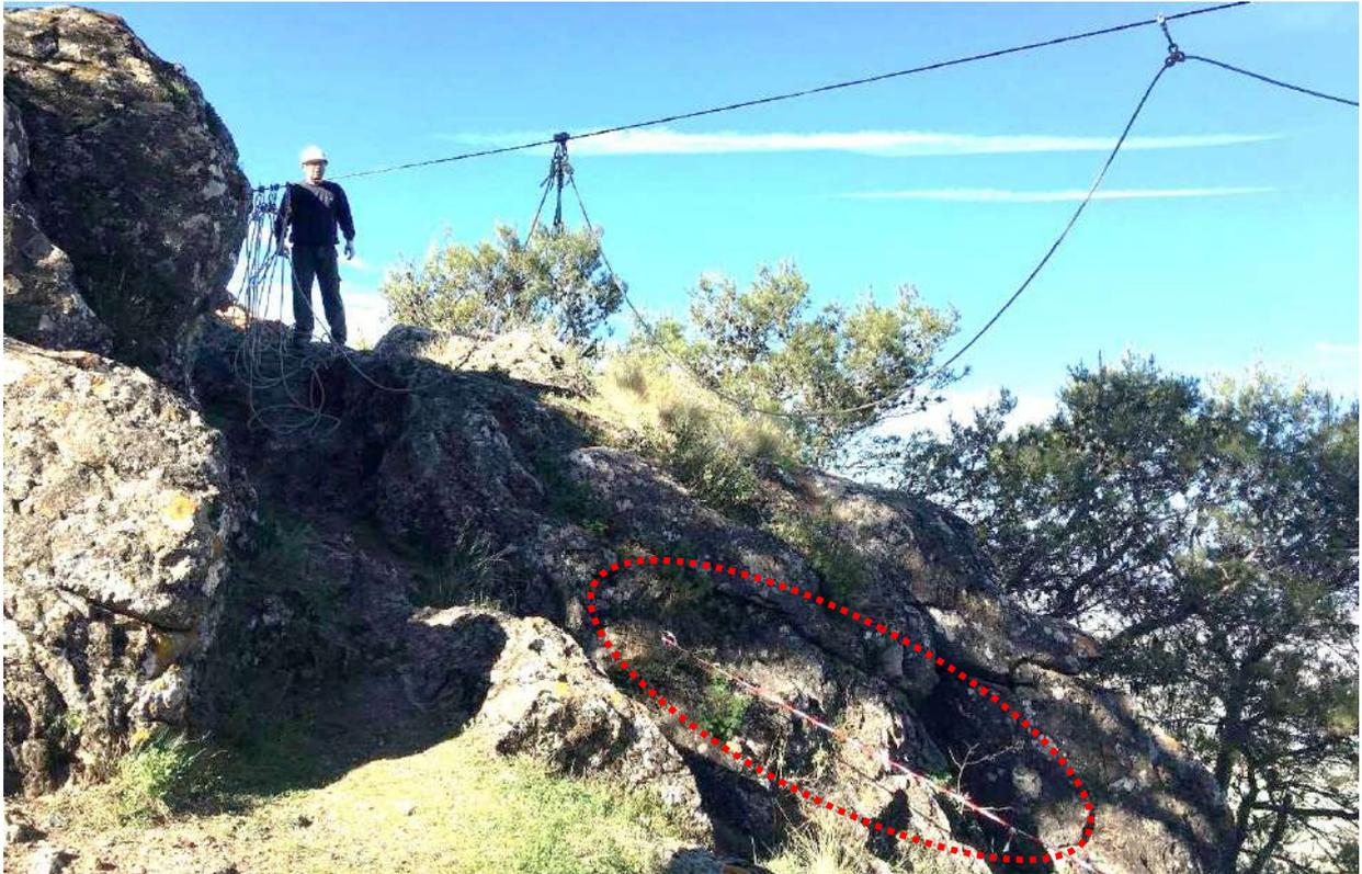
Foto 4. Sistema de acopio de material, mediante una catenaria. A la derecha, tras la banda señalizadora (línea roja de puntos), la zona a proteger del tránsito a la obra por la existencia de vegetación autóctona.
