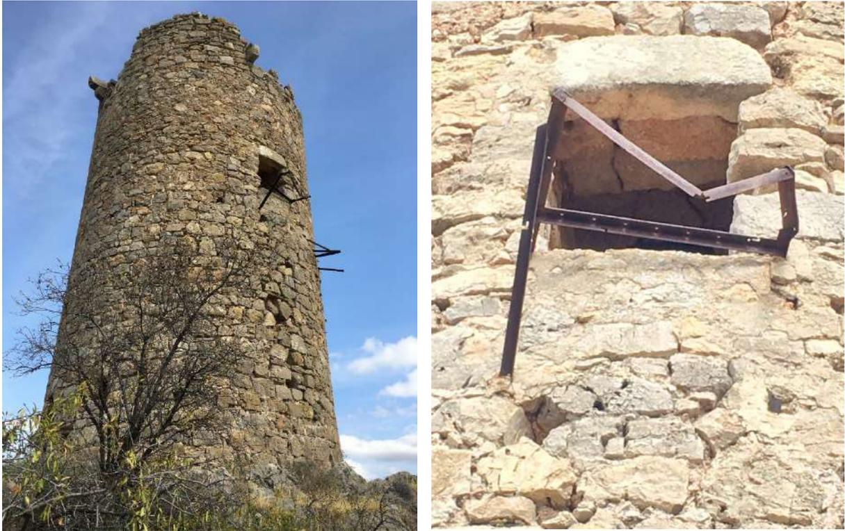
Foto 14. Alzado de la torre del Morchón. Podemos ver la solución adintelada a la derecha.
